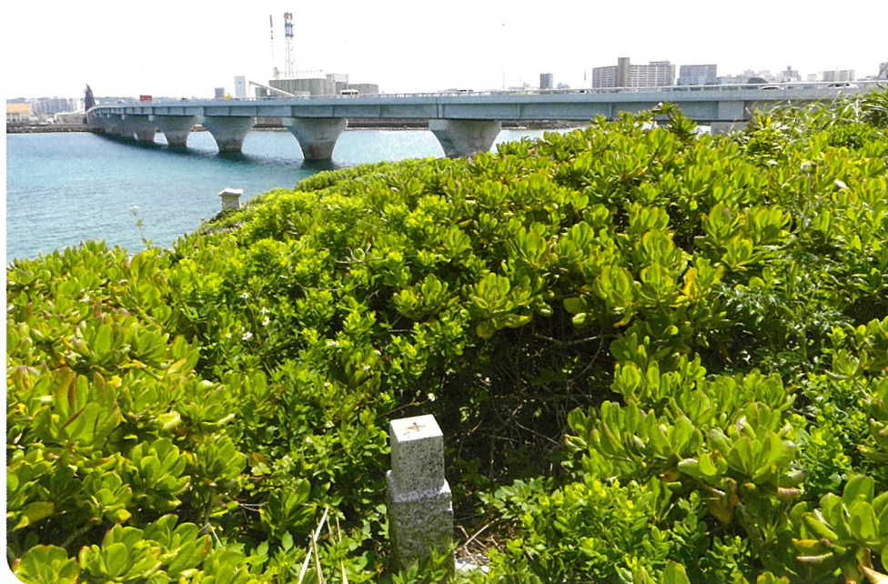
三角点「空寿崎」と港川橋
