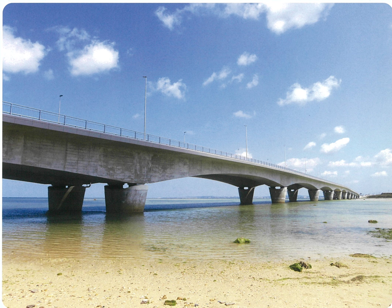
カーミージー（亀瀬）橋
