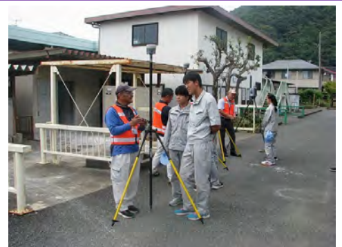
出前授業 GNSS(GPS)ネットワーク型RTK法による埋設物の探索
